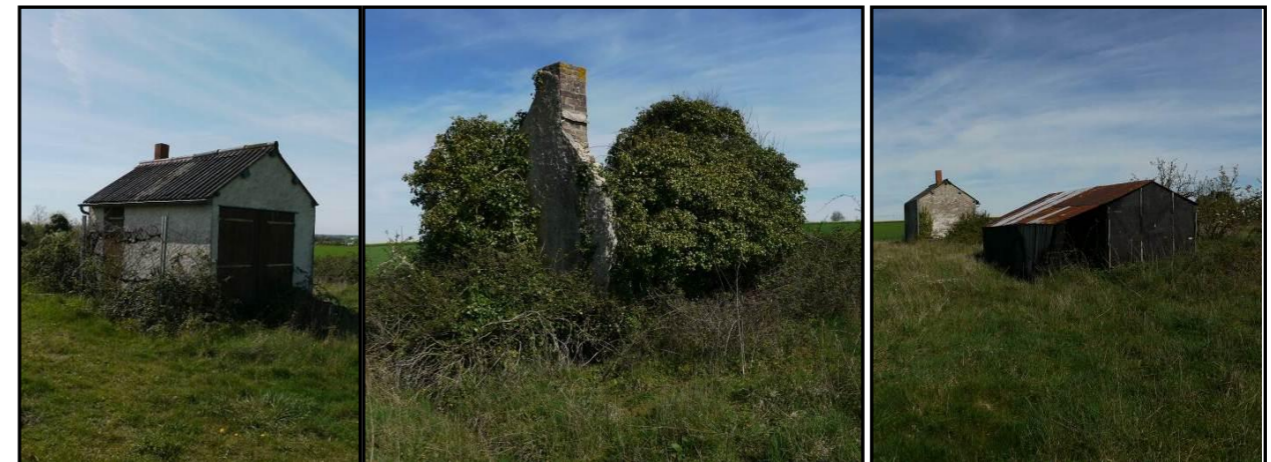
Illustration 72 : Ruines sur le site du projet
