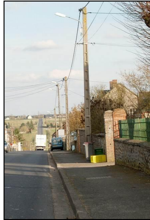
Illustration 80 : Absence d'espaces publics sur les bords de la RD157, à Danzé
