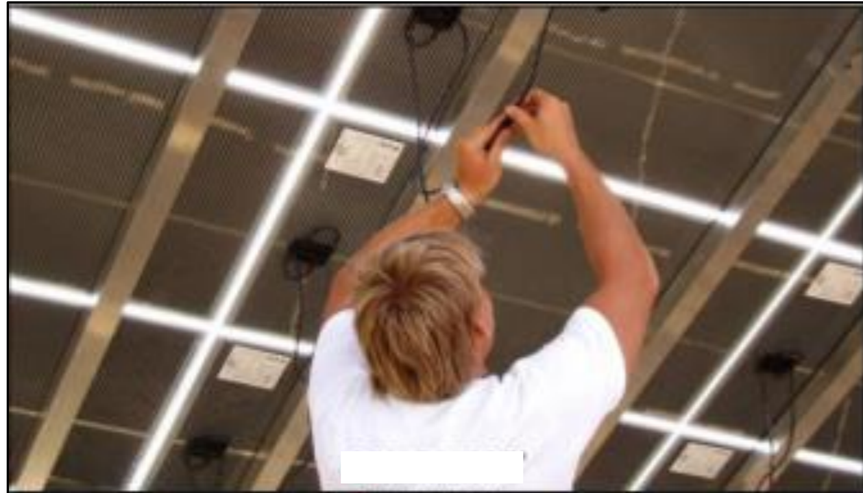
Illustration 111 : Vues des interstices de 2 cm entre chaque panneau
