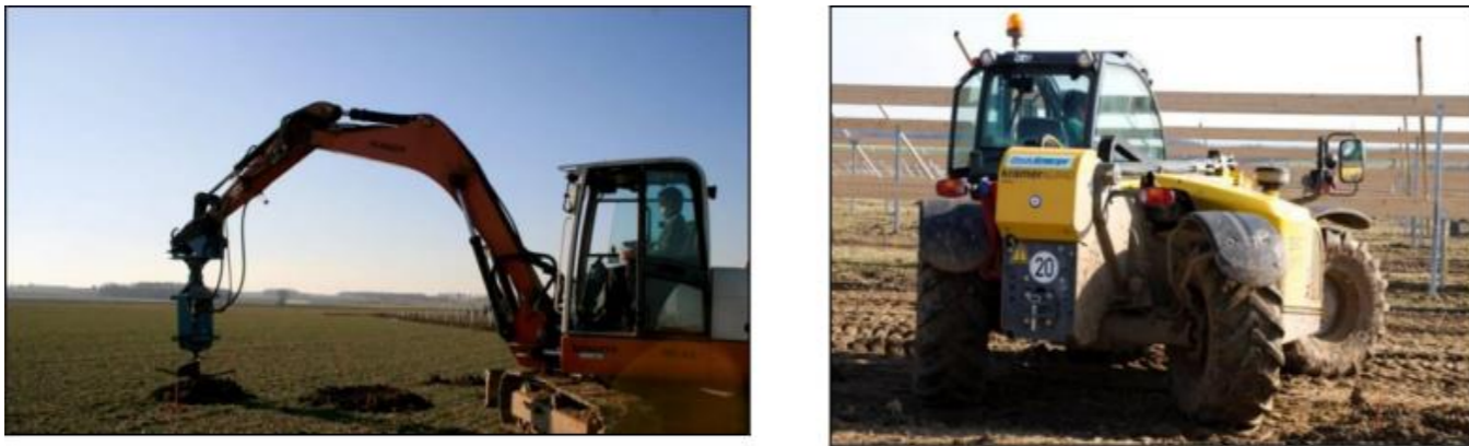
Illustration 19 : Exemple d'engins nécessaires sur le chantier
