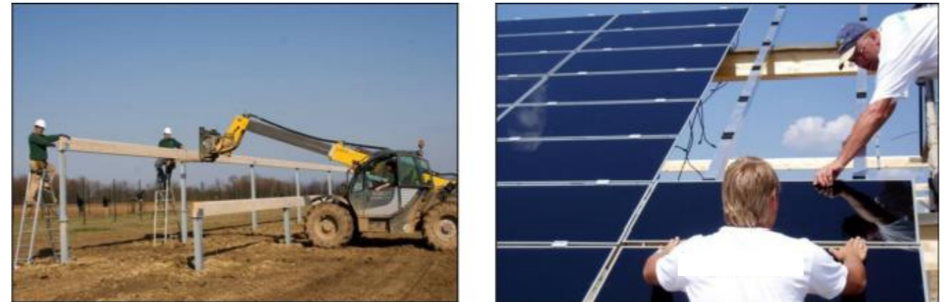
Illustration 20 : Montage des structures porteuses et des modules
